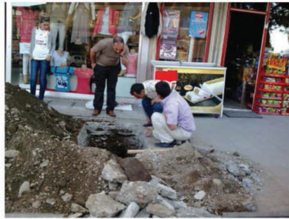
ESKİ MAL MEYDANI SÖKÜM ÇALIŞMALARI
