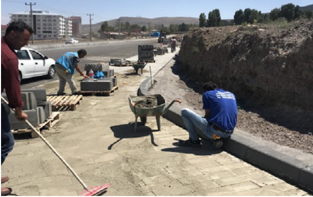
Şehit Tuncay Yurdağül Caddesi Orta Refüj Yapımı
