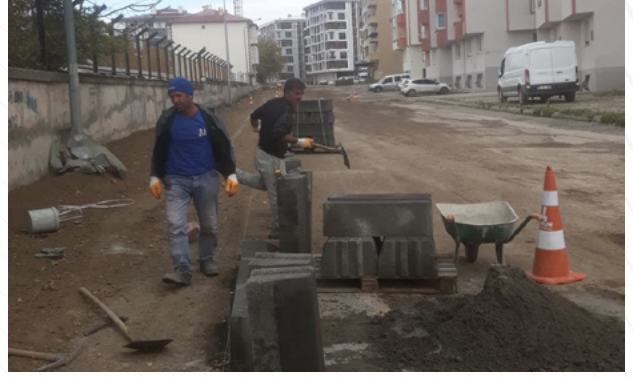
Veyisefendi Konutlari Taş Duvar Çalışması
