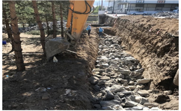
Toki Cami Perde Duvar Yapımı
