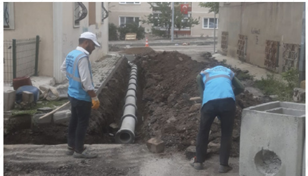
Kurtderesi 200'lük Yağmursuyu Çalışması
