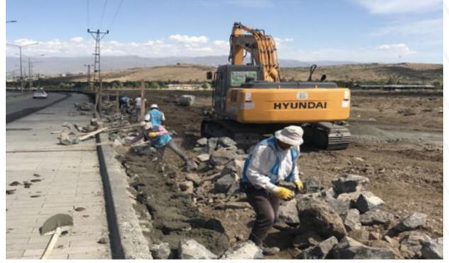
Zübeyde Hanım Anaokulu Taşduvar Yapımı
